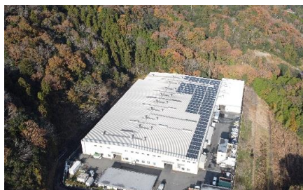
太陽光パネル設置状況
